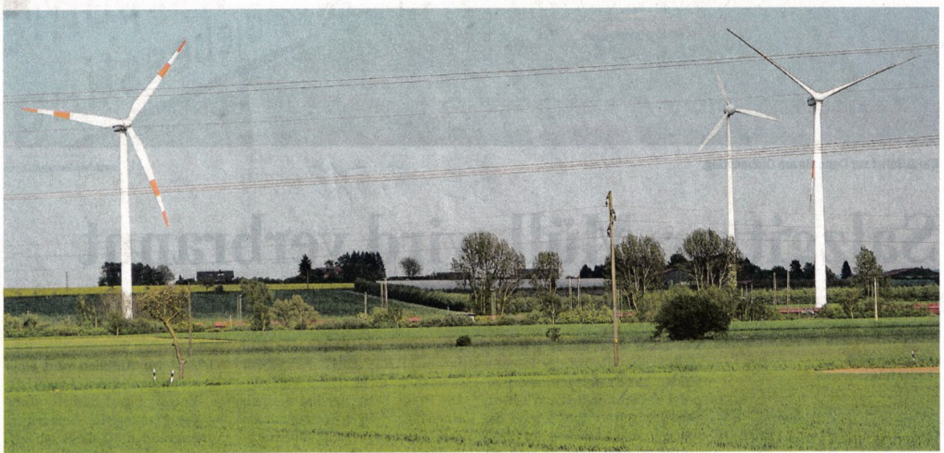
Blick über die Felder in östliche Richtung mit dem Windpark bei Geitelde und den Gleisanlagen des Umladebahnhofs Beddingen.
